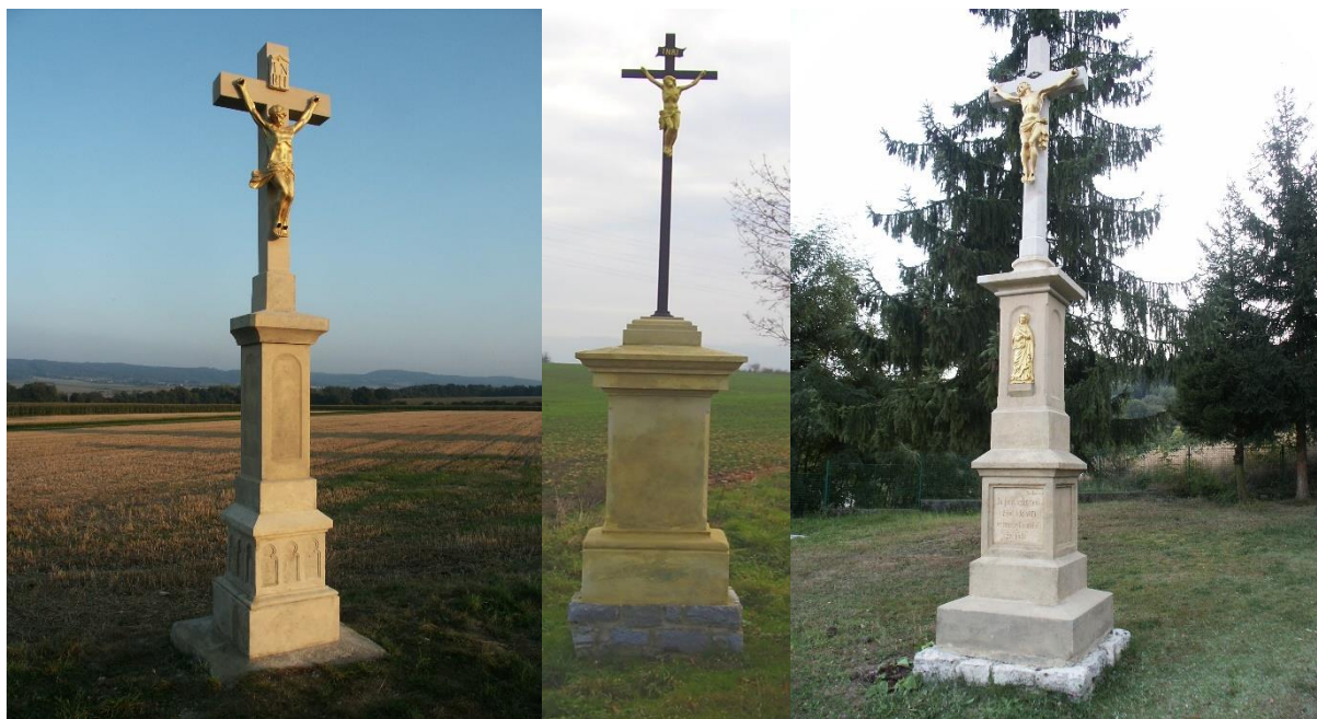
Opravené kříže v obci Borotín-směr V.Opatovice, směr Vanovice a na hřbitově. Foto Vl. Hladil 2016
